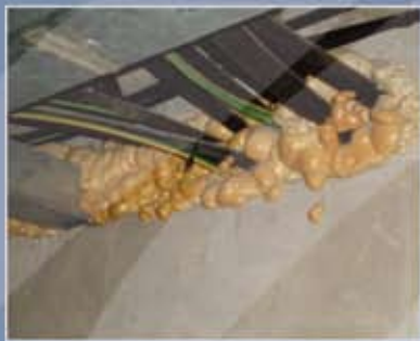
Incorrectly installed PU Foam
